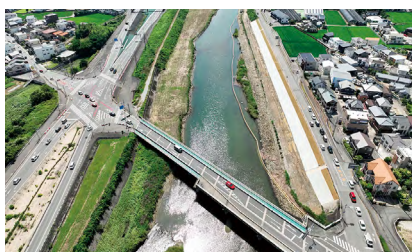
園瀬川堤防の補強対策が実現
